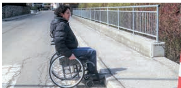
Vattaro: prima dell’intervento
