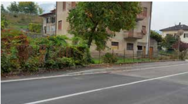
FOTO n. 7 - Il raccordo iniziale con la strada è stato realizzato posando due cordonate inclinate, assenza di gradino
