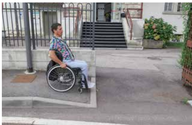
FOTO n. 4 - Marciapiede dopo dell'intervento
