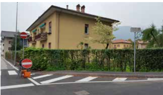
FOTO n. 7 - Il raccordo iniziale con la strada è stato realizzato posando due cordonate inclinate, assenza di gradino
