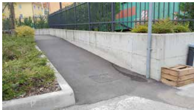
FOTO n. 3 - Marciapiede prima dell'intervento
