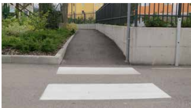
FOTO n. 1 - Marciapiede prima dell'intervento
