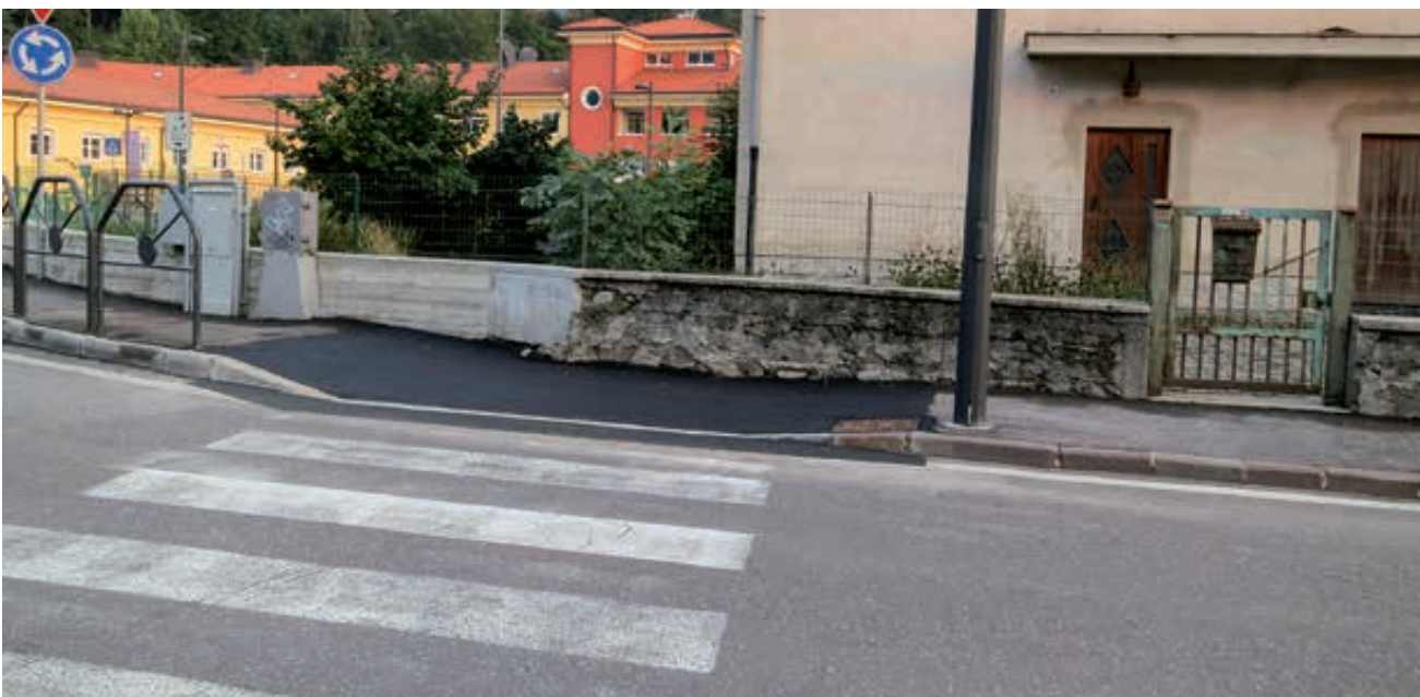
Attraversamento Via Spolverine dopo l'intervento
