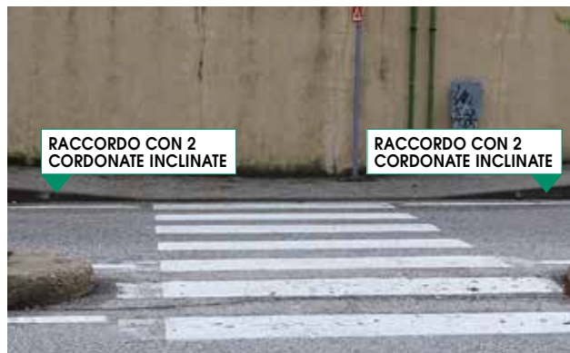
Errato raccordo strada-marciapiede pendenza trasversale 17%
