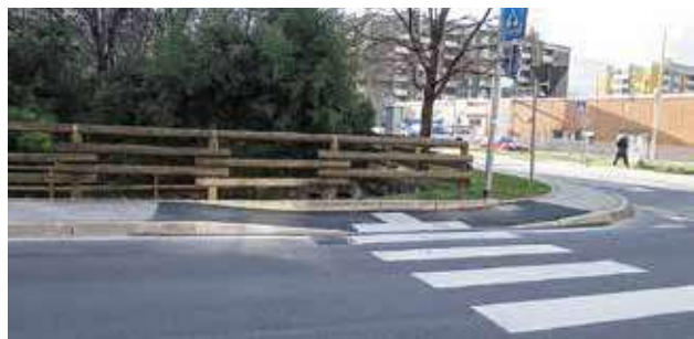
Risultato DOPO l'intervento
