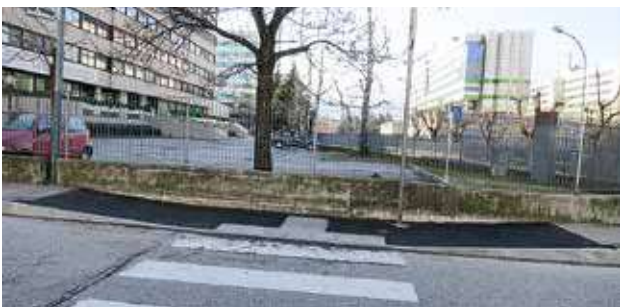
Risultato DOPO l'intervento
