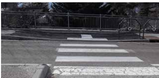
Risultato DOPO l'intervento
