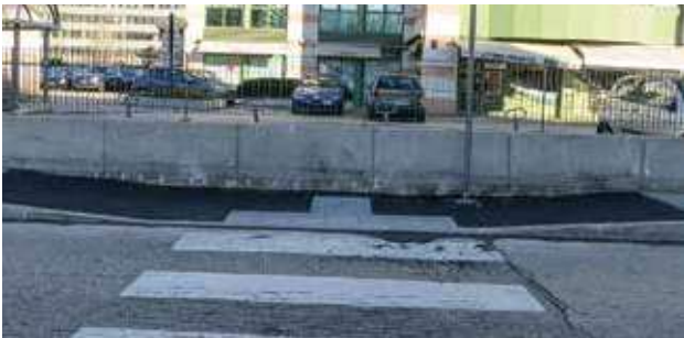
Risultato DOPO l'intervento
