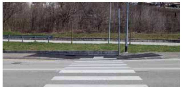
Risultato DOPO l'intervento
