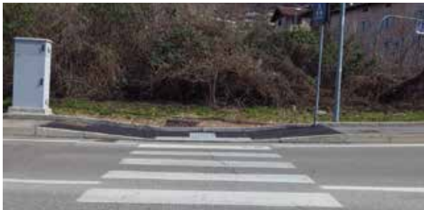
Risultato DOPO l'intervento
