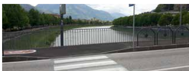
Risultato DOPO l'intervento
