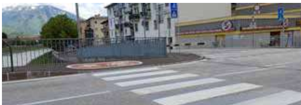
Risultato DOPO l'intervento
