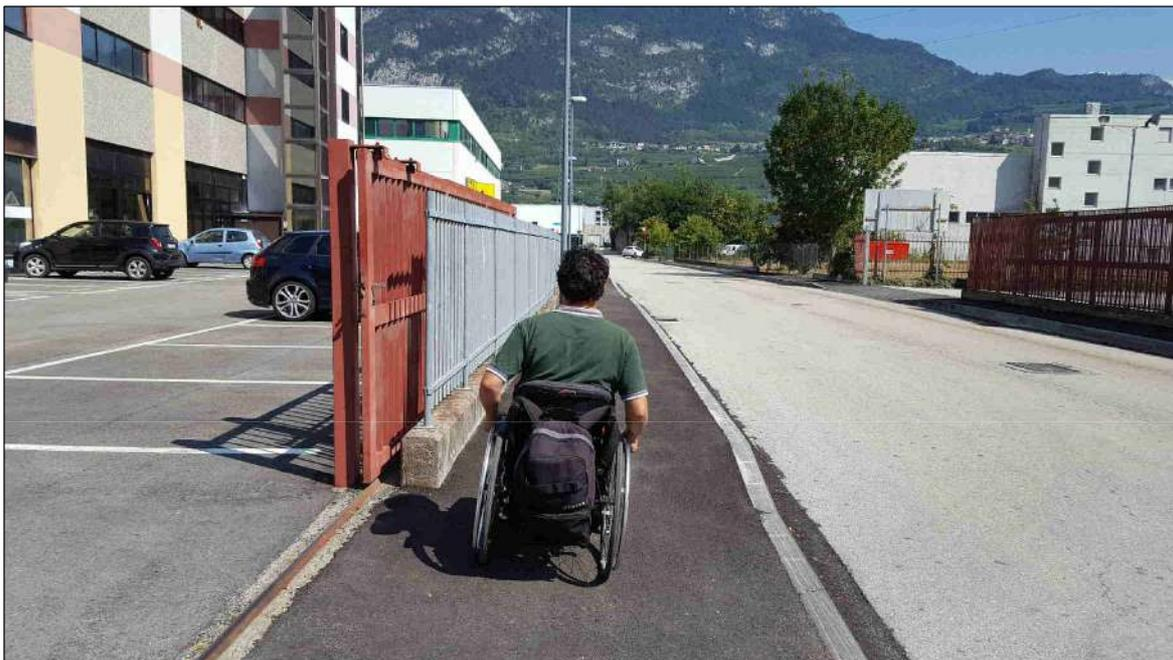
**Raccordo accesso carraio errato pendenza trasversale >1.00%**
