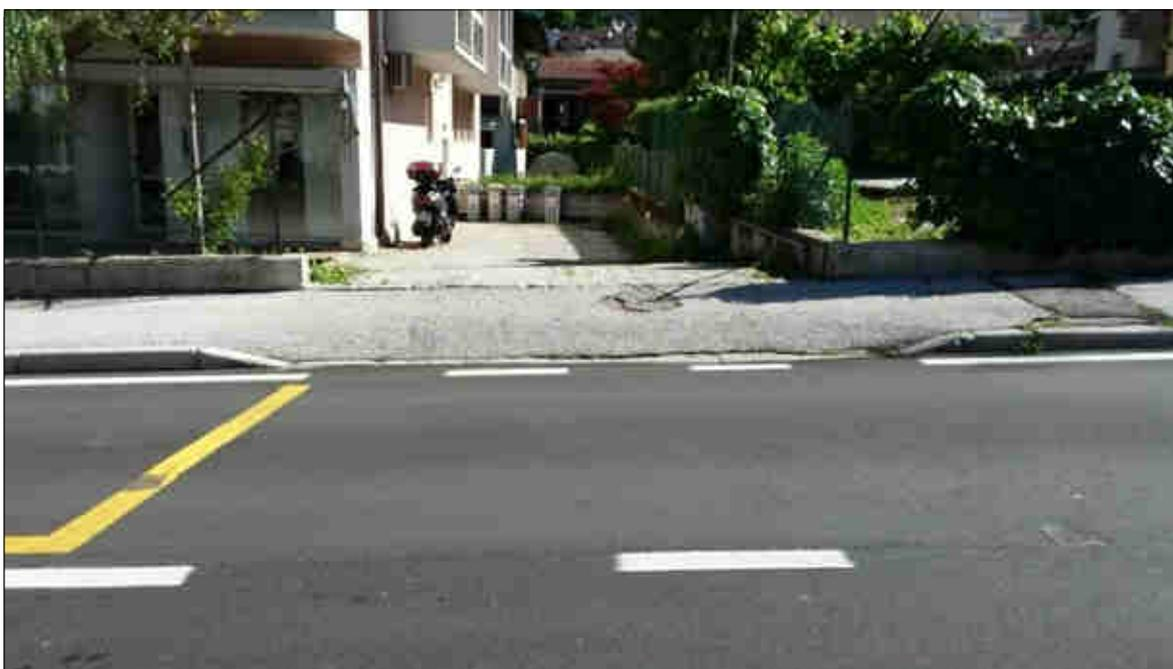
**Raccordo accesso carraio errato pendenza trasversale >1.00% ( 11% - 25.7%)**
